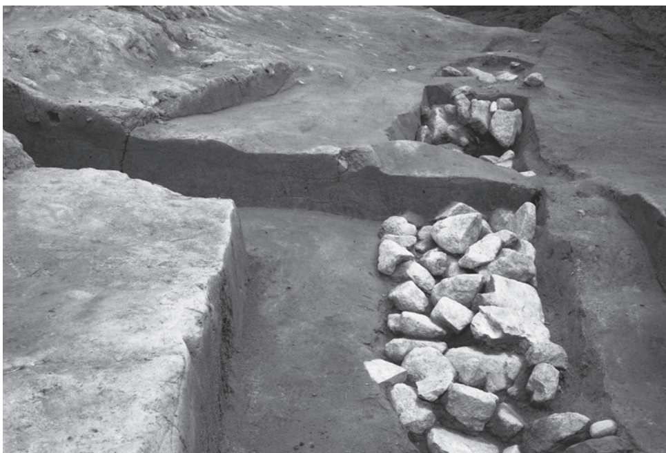
2 排水溝 (北から)
